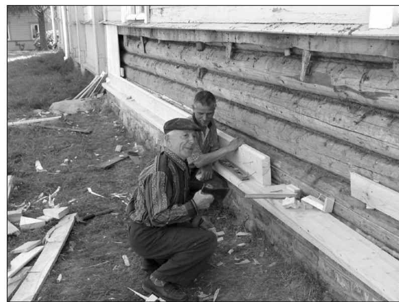
Идет замена внешней обшивки моленной
