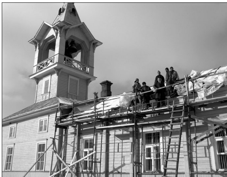
Идут строительные работы
